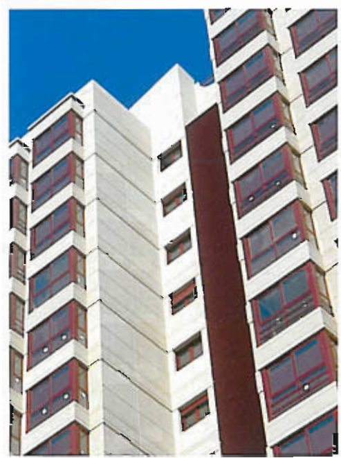
Panel de Hormigón Arquitectónico que cubre la altura de planta a planta, con hueco integrado para la carpintería de aluminio; apoyando por su parte superior. Junta horizontal por solapa.
