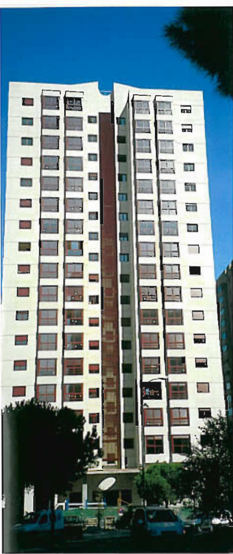
Panel de Hormigón Arquitectónico que cubre la altura de planta a planta, con hueco integrado para la carpintería de aluminio; apoyando por su parte superior. Junta horizontal por solapa.
